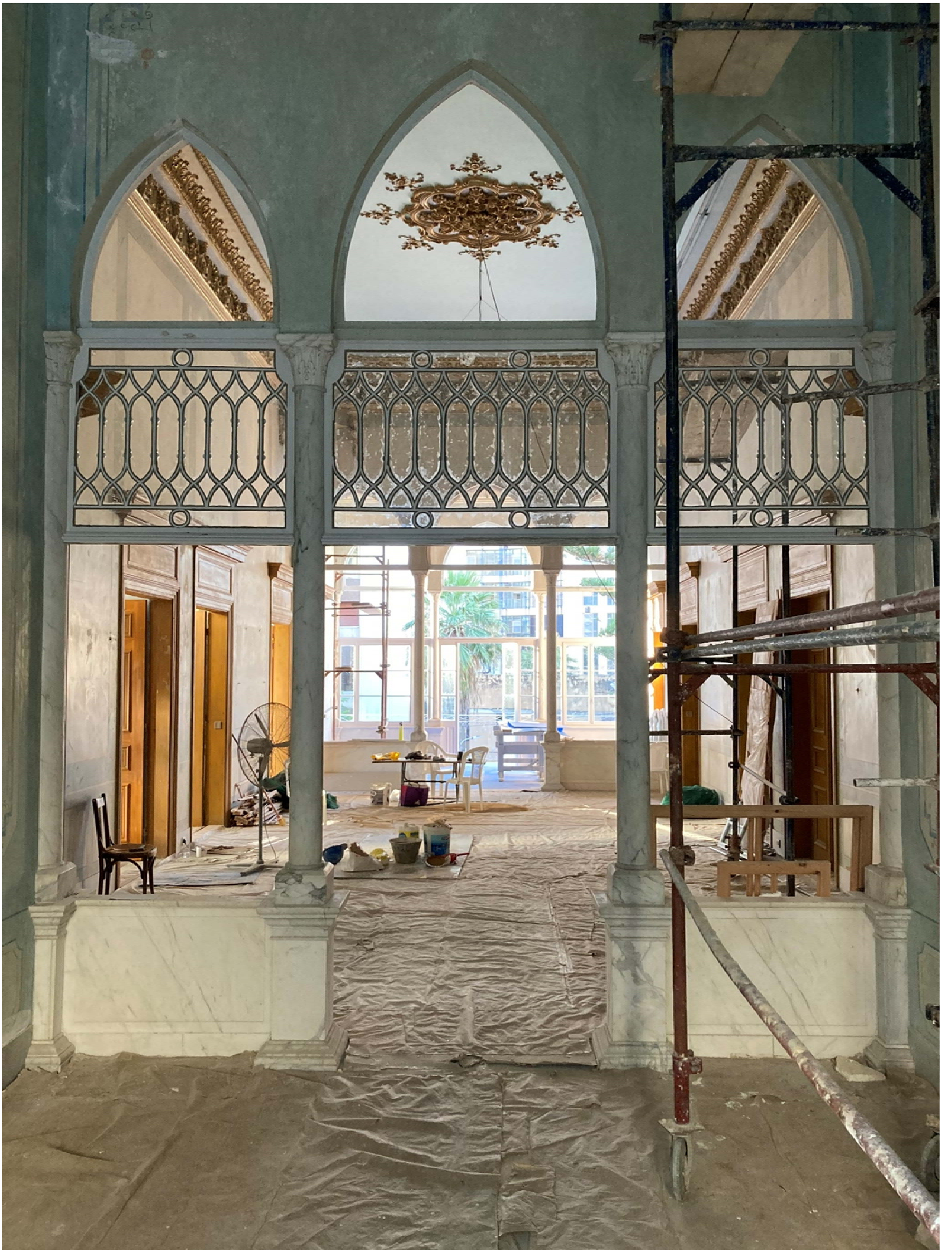
Maison Dagher pendant les travaux de restauration, rue Gouraud, Beyrouth, Photo Fadlallah Dagher
